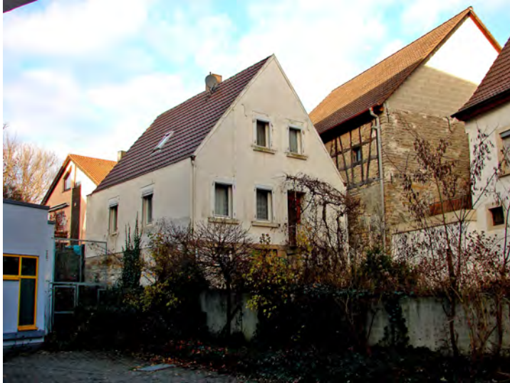
Abbildung 45: Das ehemalige Haus in der Schulstraße 5, welches im Februar 2014 abgerissen wurde.
