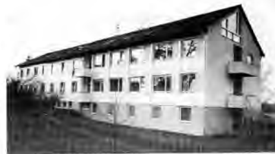
Krankenhaus Neuenstadt mit Erweiterungsbau
