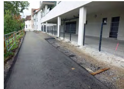
Abbildung 65: Neuverlegung nach Abschluss eines Neubaus im August 2023
