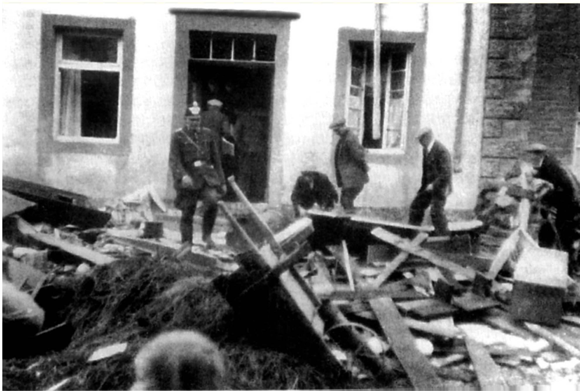
Aufräumarbeiten vor der geschändeten Synagoge
