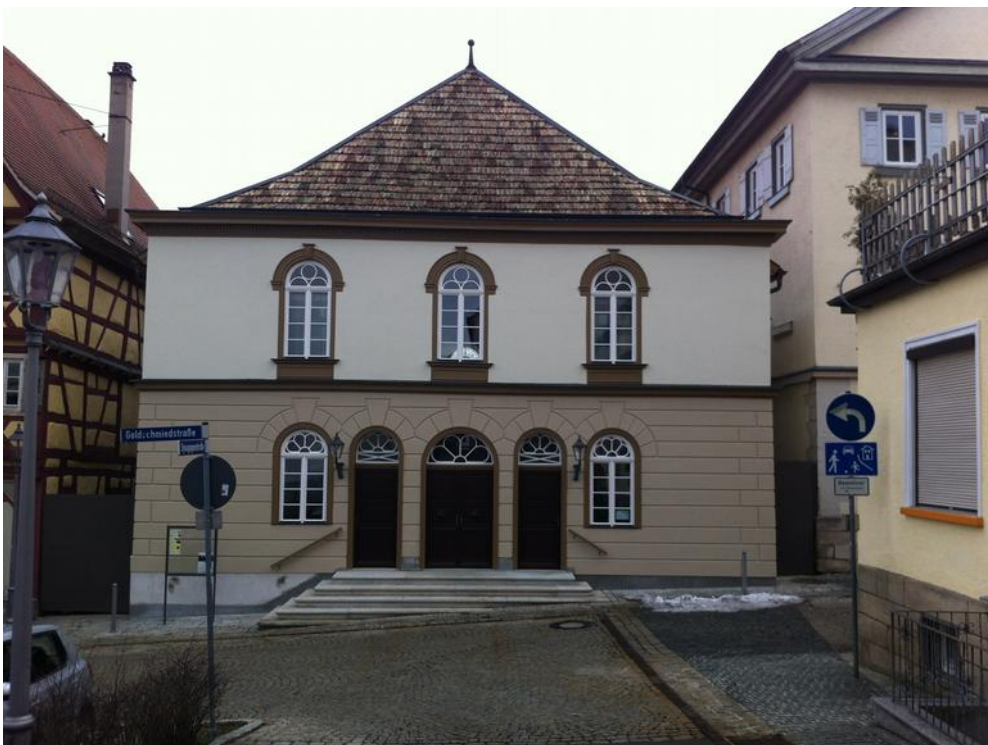
Die renovierte Fassade der Alten Synagoge Hechingen 2019. Foto: B. von Bremen
