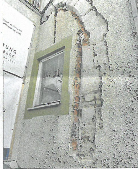
Große Fensterbögen lassen die frühere und besondere Bedeutung des Gebäudes erahnen.
