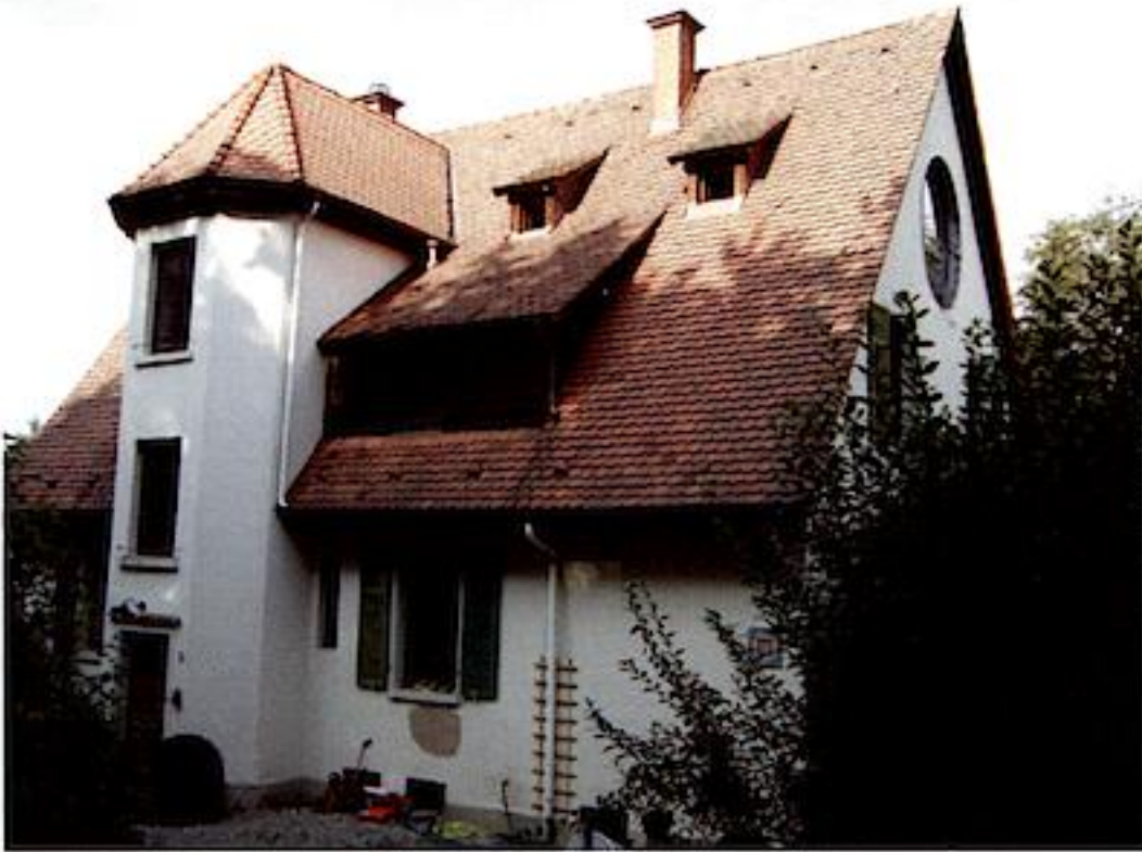
Abb. 2b Haus „Sonnenhalde“, Seitenansicht (Schadek).
