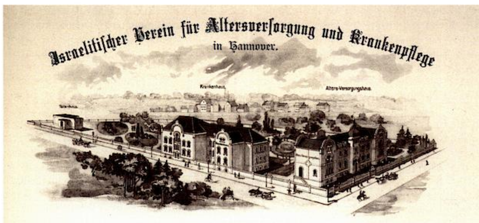
Abb. 7 Jüdisches Krankenhaus und Altersheim in Hannover (Stadtarchiv Hannover).
