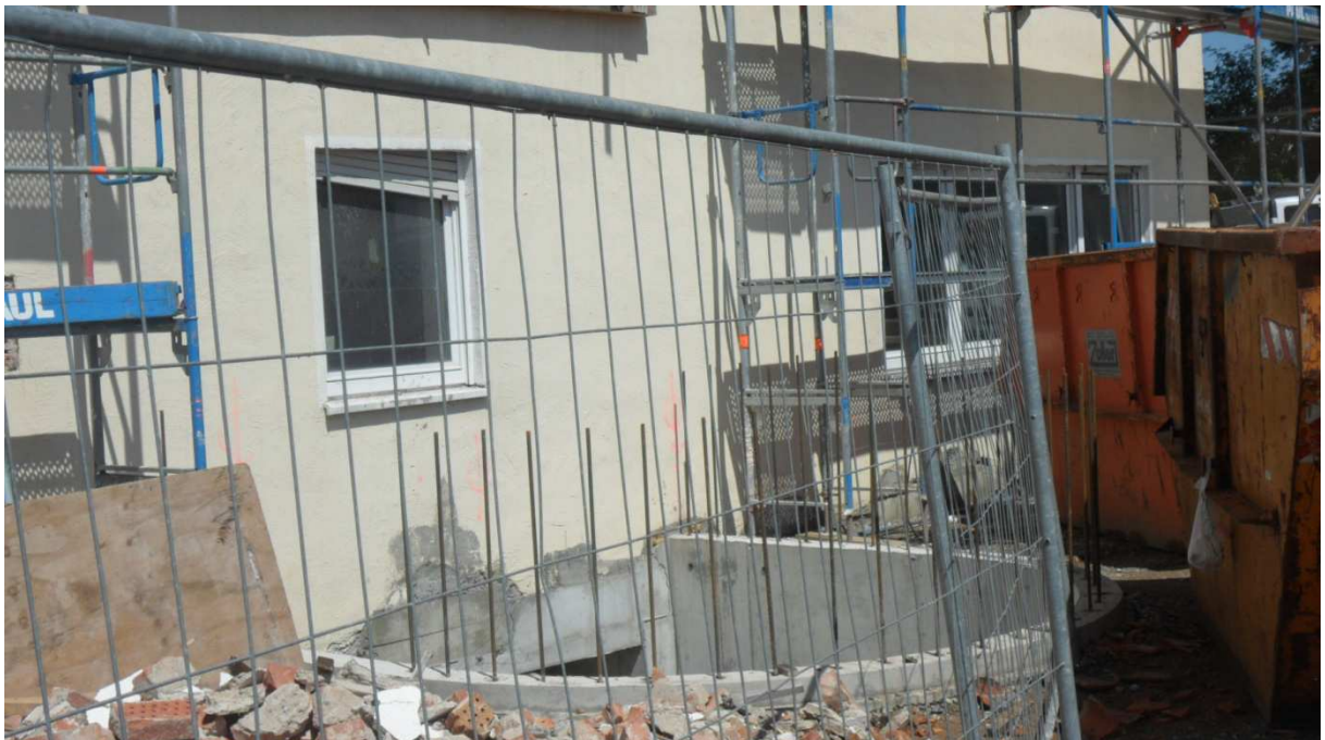
Bild 1: Dachdeckerarbeiten, Bild 2, Fundament des zukünftigen Treppenturms auf der Südseite
