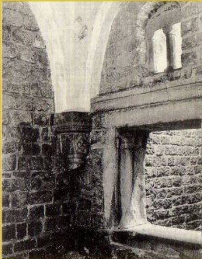
Fenster im Vorraum des Ritualbades mit Blick in den Badeschacht.
