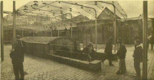
▼ Eingang zum Ritualbad mit Glasüberdachung.
