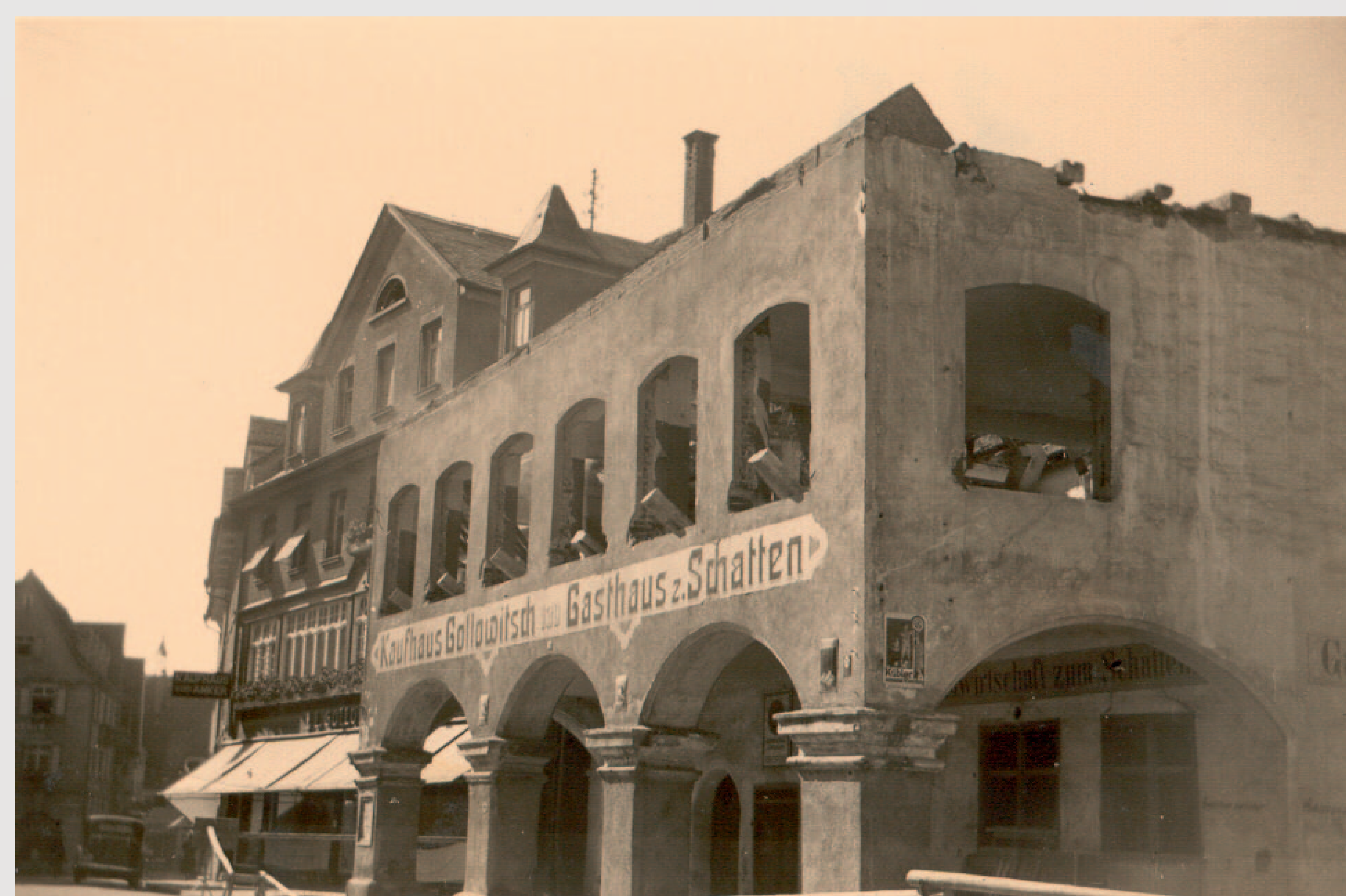
Abb. 2: Abbruch Gasthaus zum Schatten, 1938
