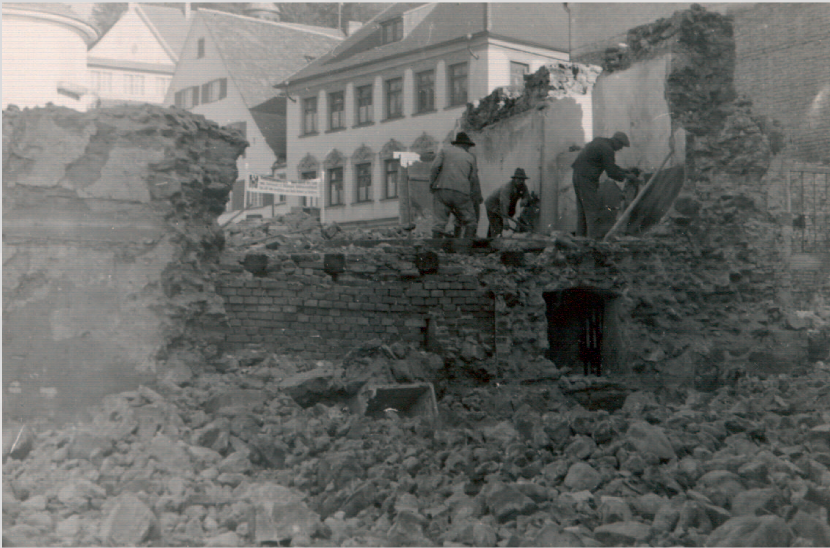
Abb. 39: Abbruch Gasthaus zum Schatten, 1938
