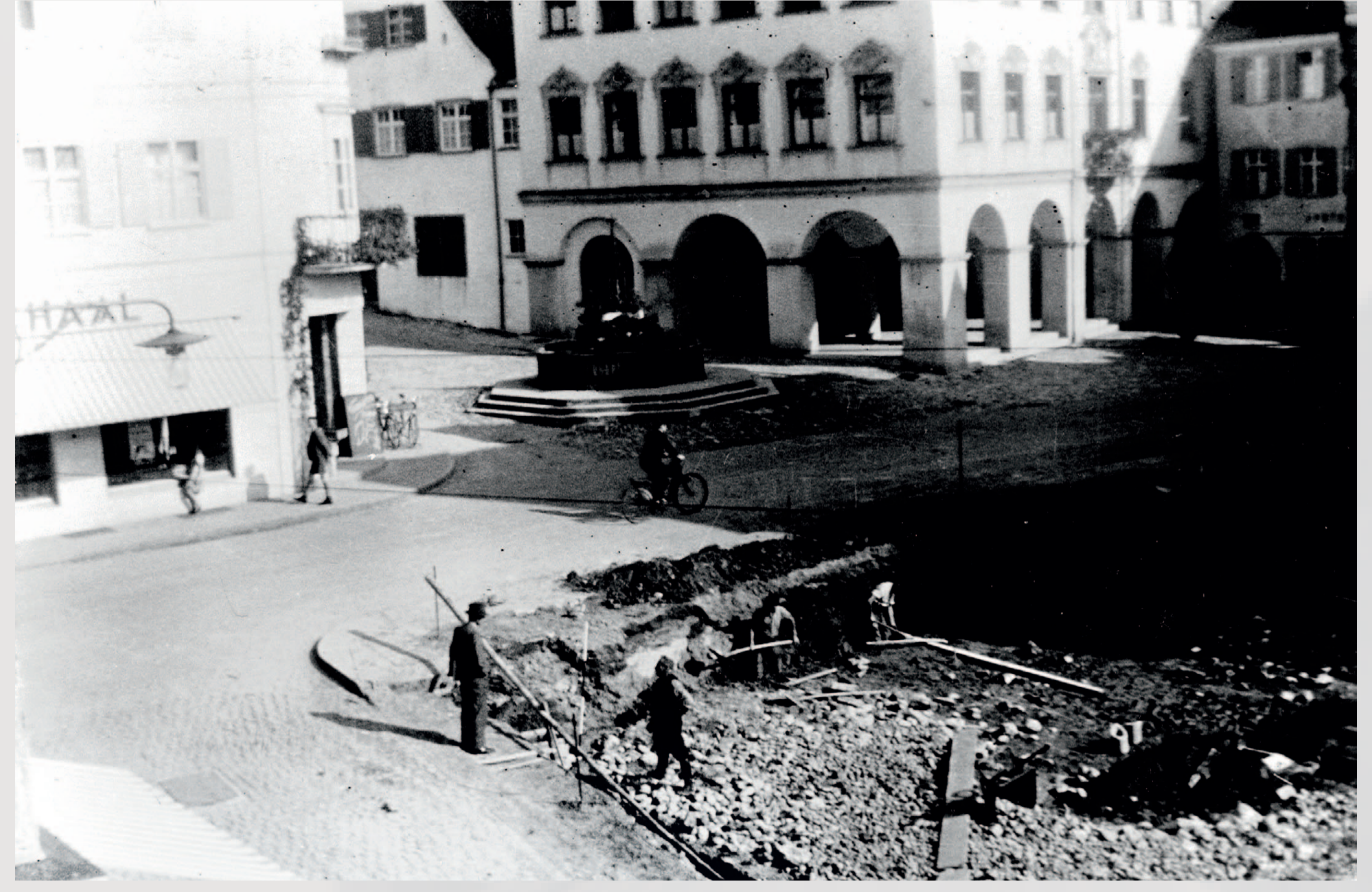
Abb. 36: Abbruch Gasthaus zum Schatten, 1938
