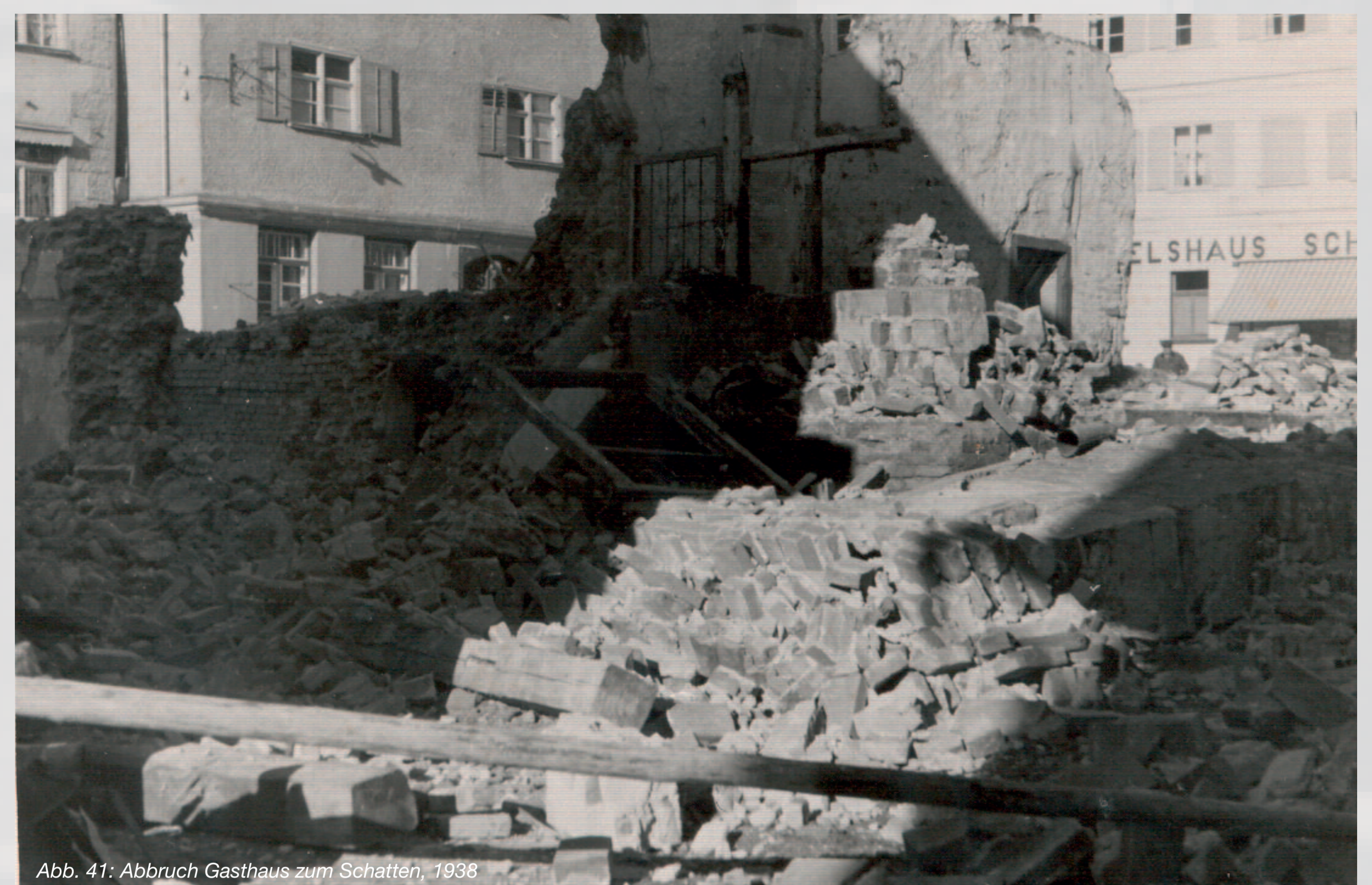
Abb. 41: Abbruch Gasthaus zum Schatten, 1938
