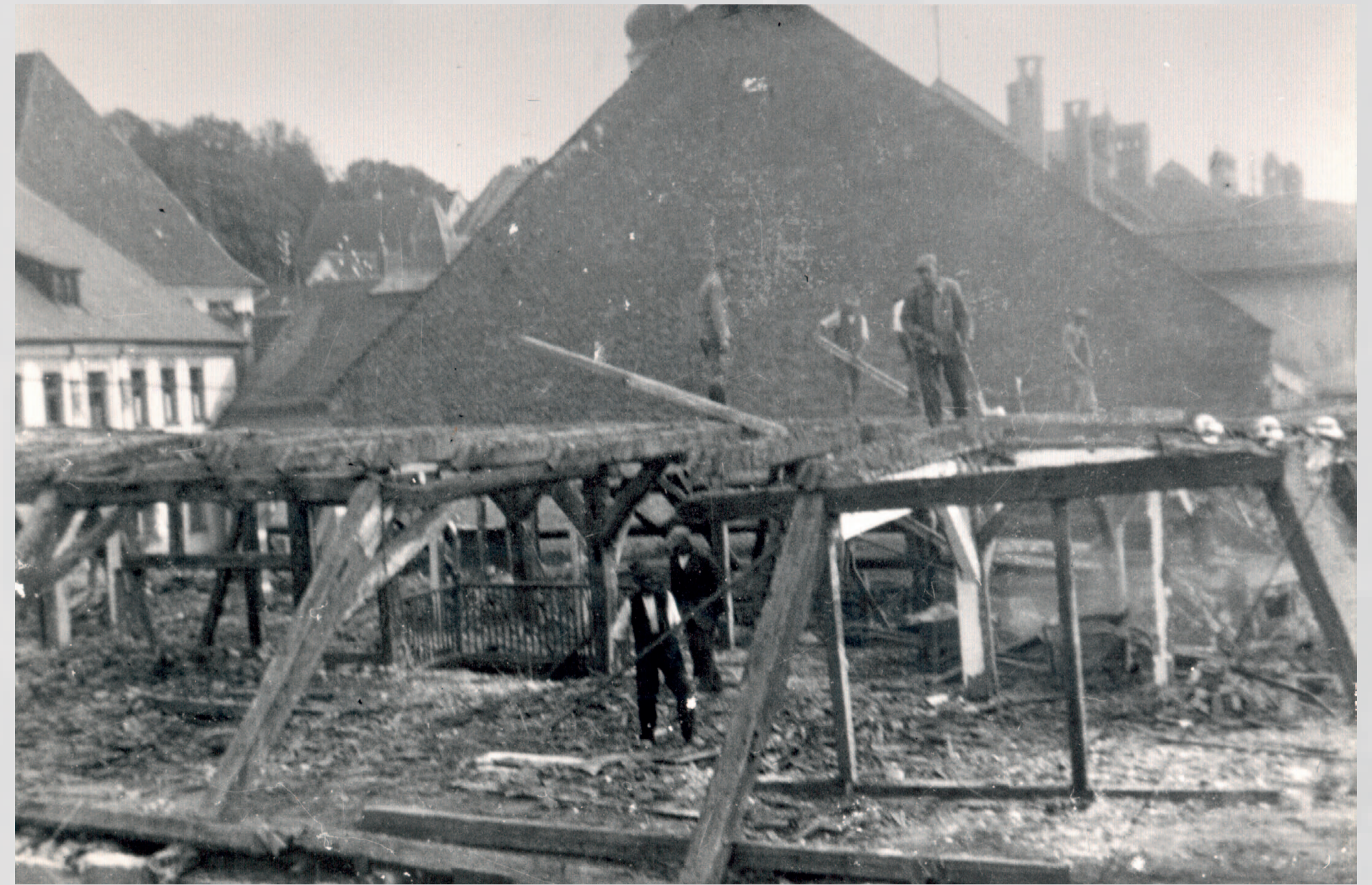
Abb. 40: Abbruch Gasthaus zum Schatten, 1938
