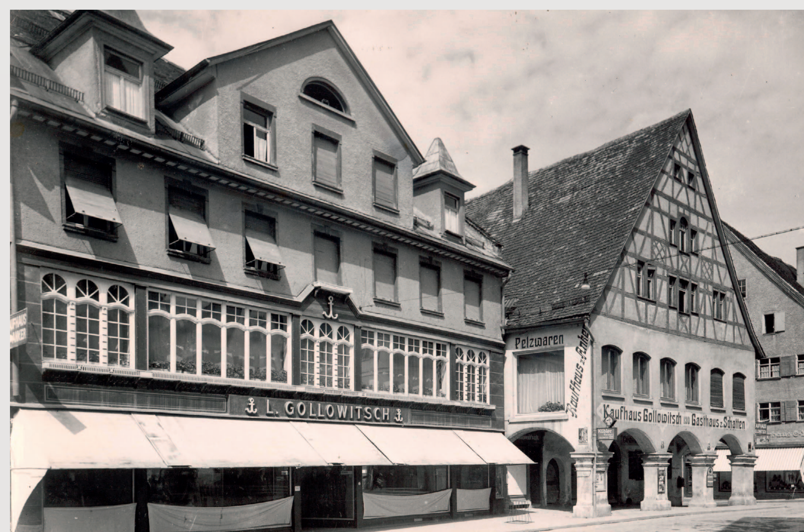
Abb. 1: Kaufhaus Gollowitsch und Gasthaus zum Schatten
