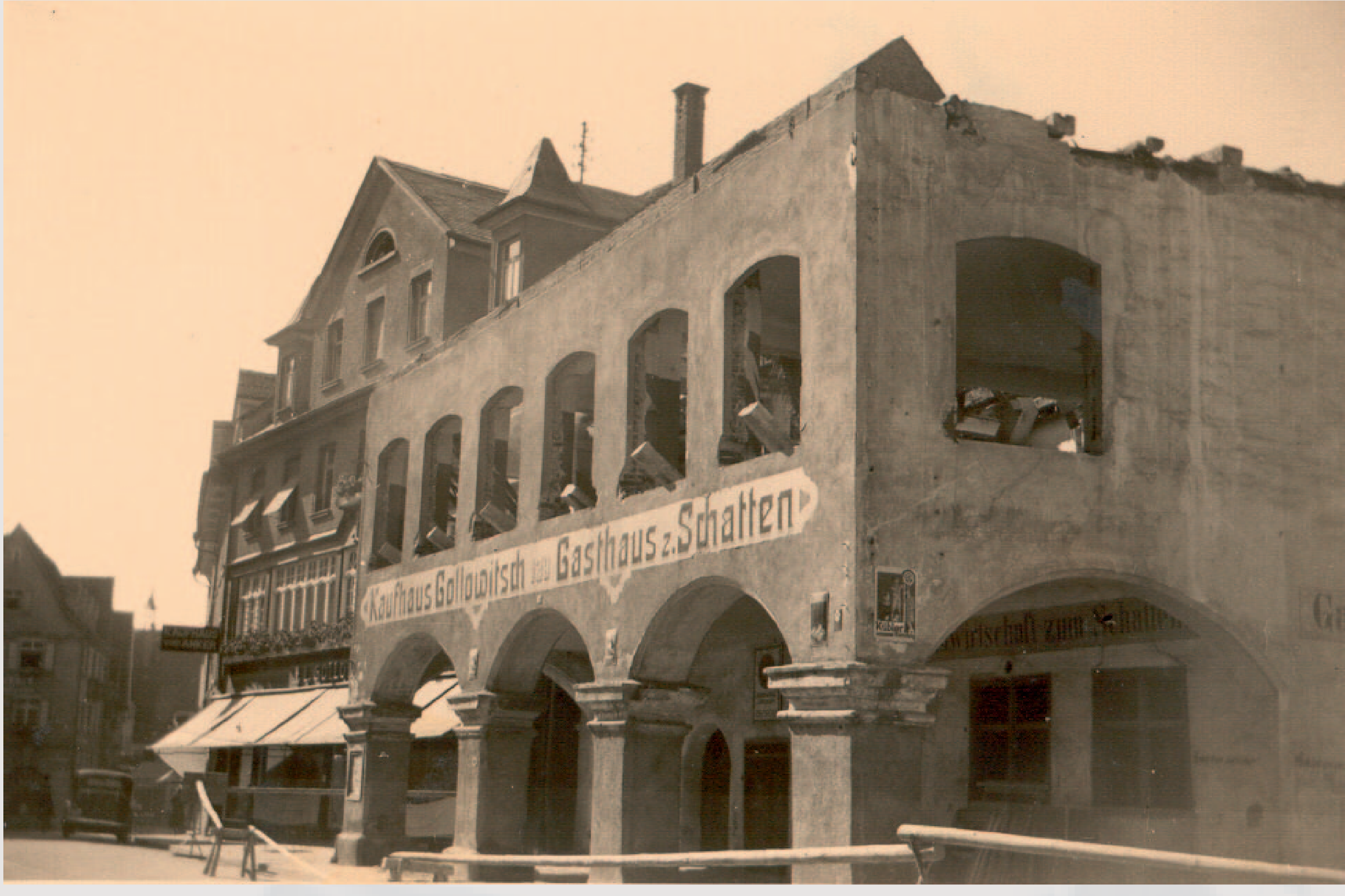
Abb. 35: Abbruch Gasthaus zum Schatten, 1938
