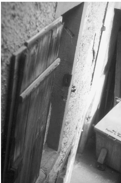
Abb. 10: Spuren jüdischen Lebens. Schlitz für eine Mesusah im rechten Türpfosten, Bad Mergentheim, Gänsmarkt 5/2. Stock. Mittlerweile abgerissen. Türe wird im Deutschordensmuseum aufbewahrt.
